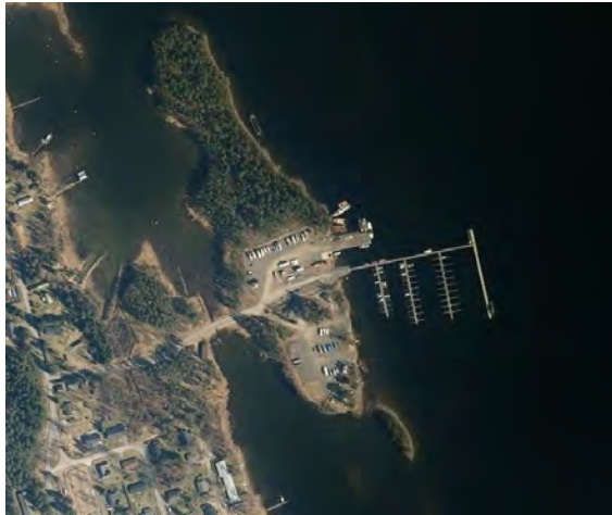
Kuva 7. Ilmakuva Anttolan jätevedenpuhdistamon sijainnista (Lähde: Paikkatietoikkuna)
